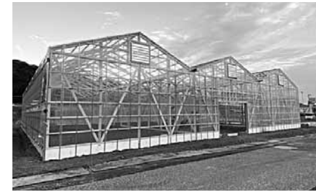
越喜来浦浜地区に建設中の夏イチゴ生産・担い手育成拠点施設
